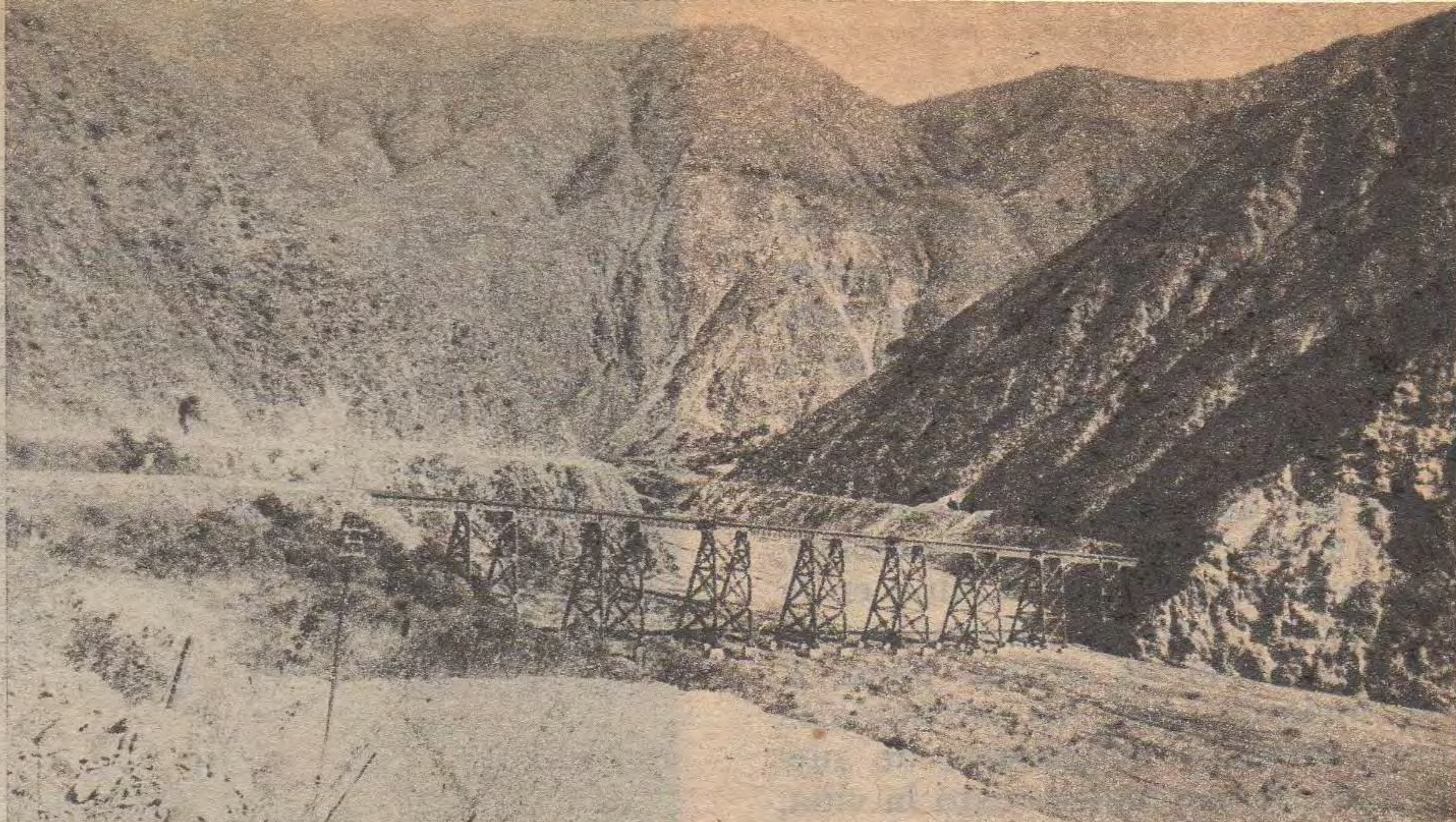
Uno de los viaductos Salta-Cobres-Socompa . Audaz obra de ingeniería.
